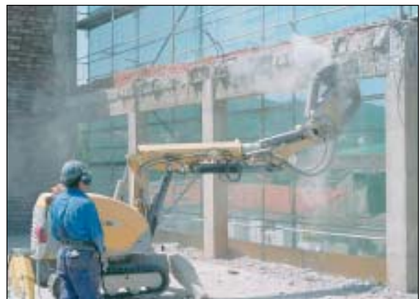
Robot de demolición
