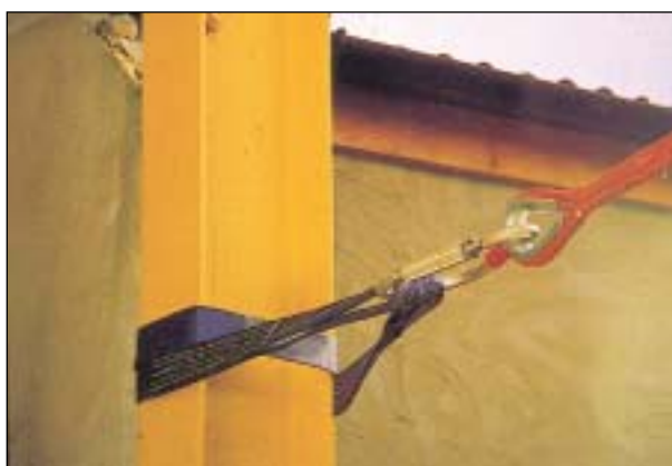
Anclaje con eslinga
