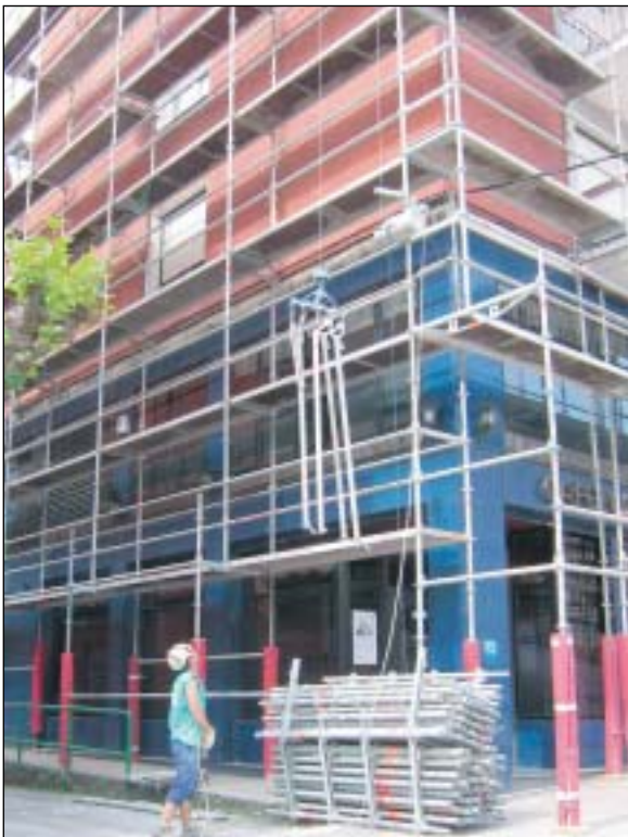
Montaje con maquinillo eléctrico
