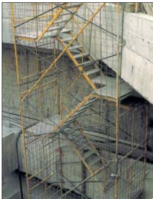
Escalera de acceso
