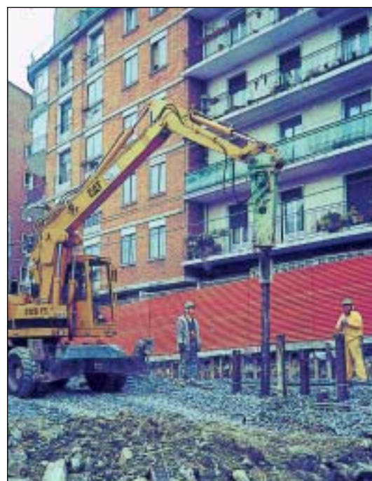
Hincado de carriles
