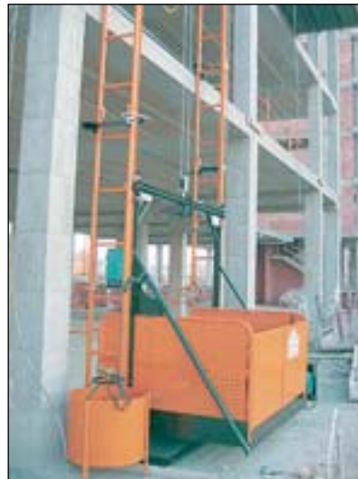
Sistema de traccion por cable
