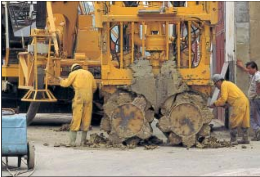
Fresadora para muros-pantalla
