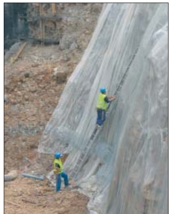
Cubrición de taludes
