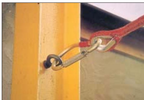
Anclaje con perno
