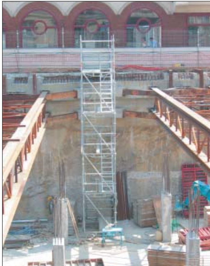
Apuntalamiento provisional y acceso
