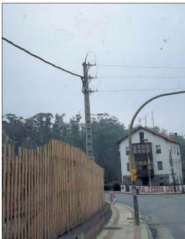
Instalación de cables aislados dentro de la obra
