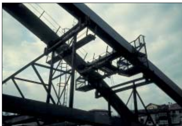
Accesos y pasarelas protegidos
