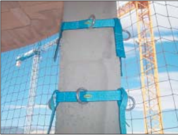
Sistema para anclaje móvil a pilares
