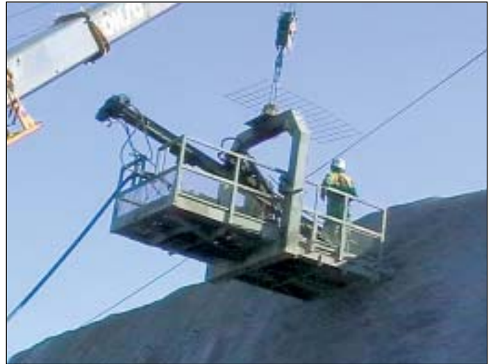
Plataforma con maquinaria y operarios
