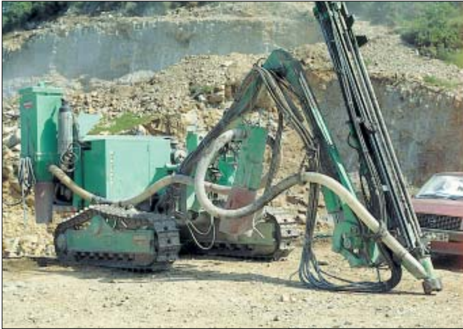
Equipo perforador con colector de polvo
