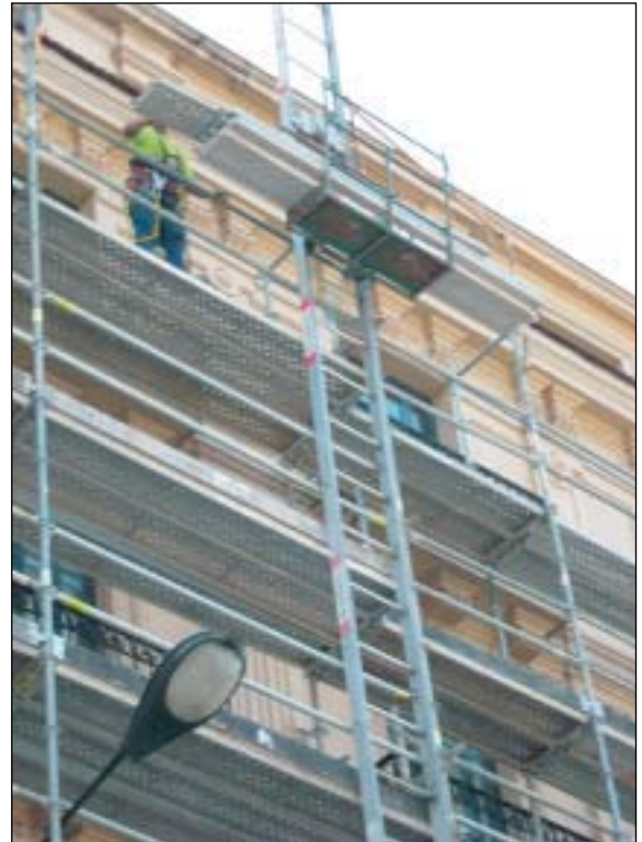
Montaje de andamio con montacargas
