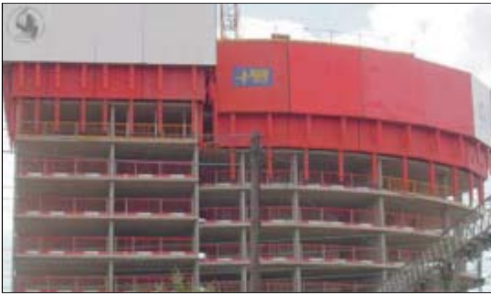
Paneles protectores trepantes (exterior e interior). Barandillas en plantas inferiores
