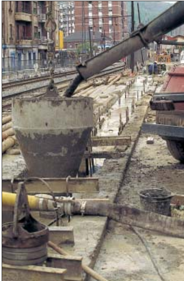
Muros-guía con canal de recogida para el lodo y tubo tremie
