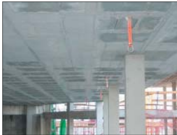
Elemento embebido para anclaje
