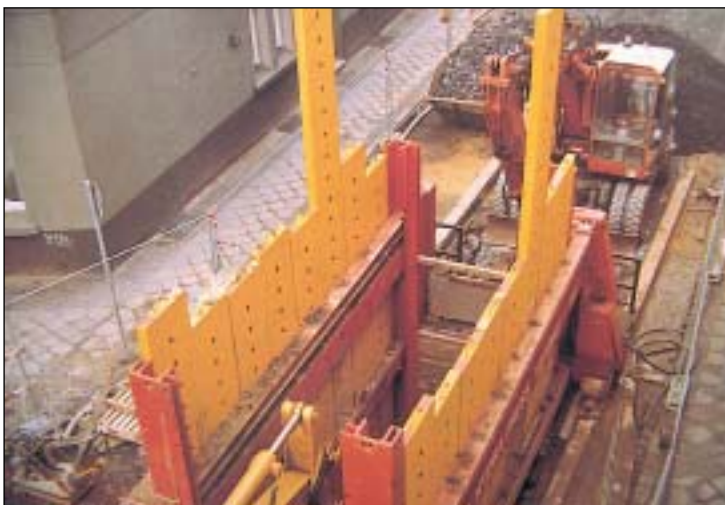
Entibación por presión hidráulica
