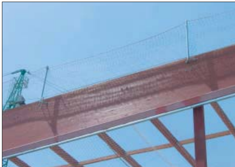
Red para colocación de las placas de cubierta
