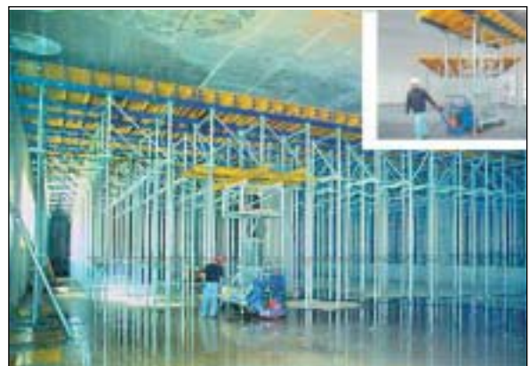
Mesas de encofrado
