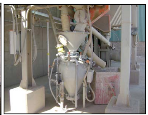
Propulsor de polvo de arcillas y quebradora, retira el polvo de los colectores con un gusano sinfín y lo manda a silos de arcilla.
